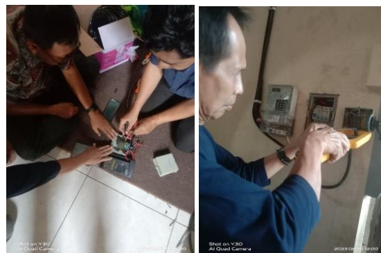
Gambar 5. Proses pengecekan dan pemasangan saklar pemindah jalur sumber listrik PLN dan Genset.
