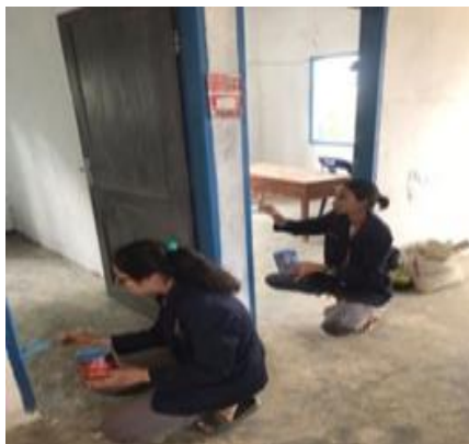
Gambar 2. Pembersihan dan pengecatan kantor desa Sumber: Hasil olahan data tahun 2024
