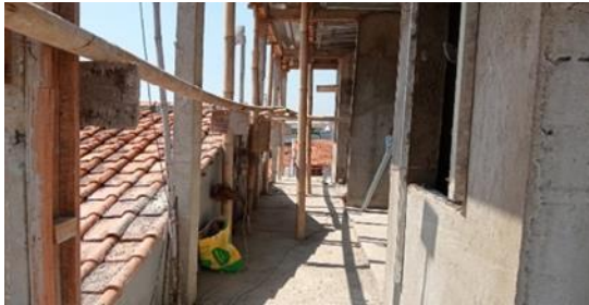
Gambar 1. Proyek renovasi rumah
